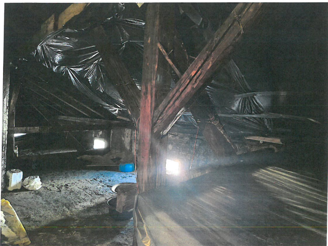
Fot. 7. Prowizoryczne zabezpieczenie przed zalewaniem
