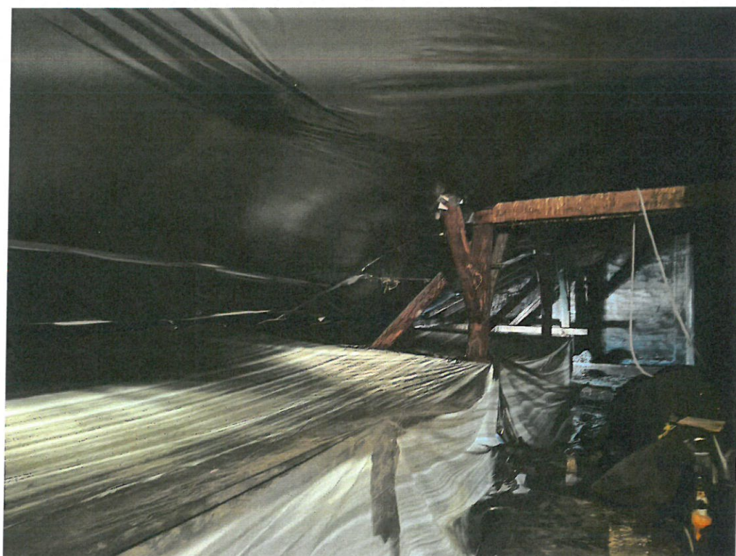
Fot. 8. Prowizoryczne zabezpieczenie przed zalewaniem
