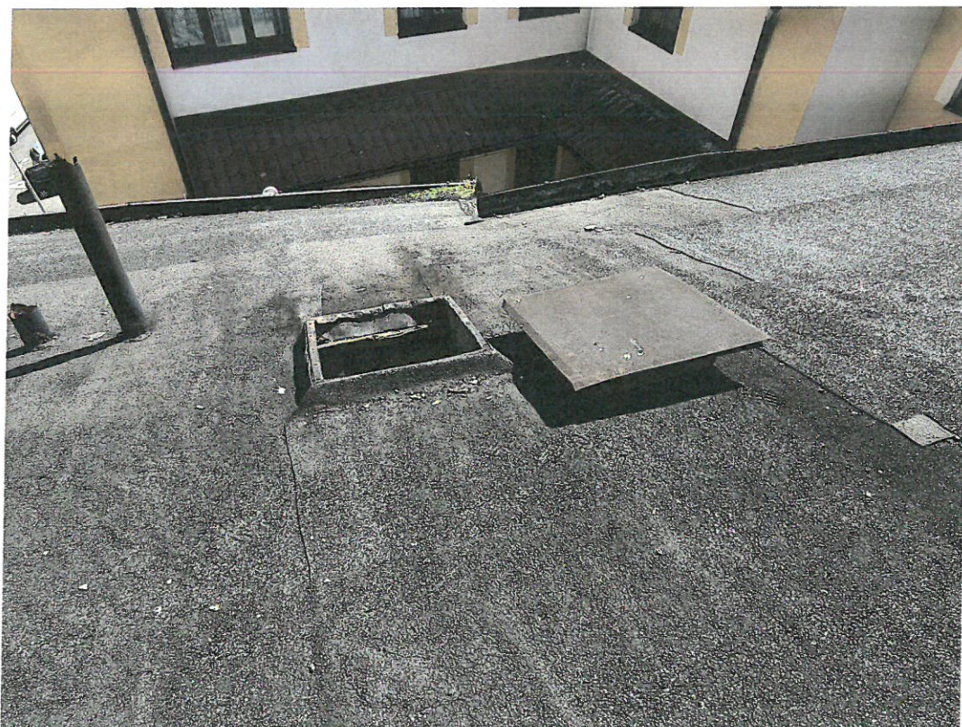
Fot. 12. Widok połaci z wyłazem dachowym, rynny leżące
